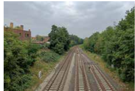
Brücke über die Bahntrasse zwischen Volkshaus und Neufert-Bau
