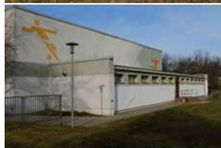
Gebäude mit Potential: Schule in der Brunnenstraße
