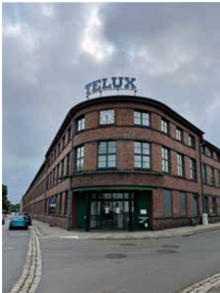
Prägende Architektur der Moderne: Telux
