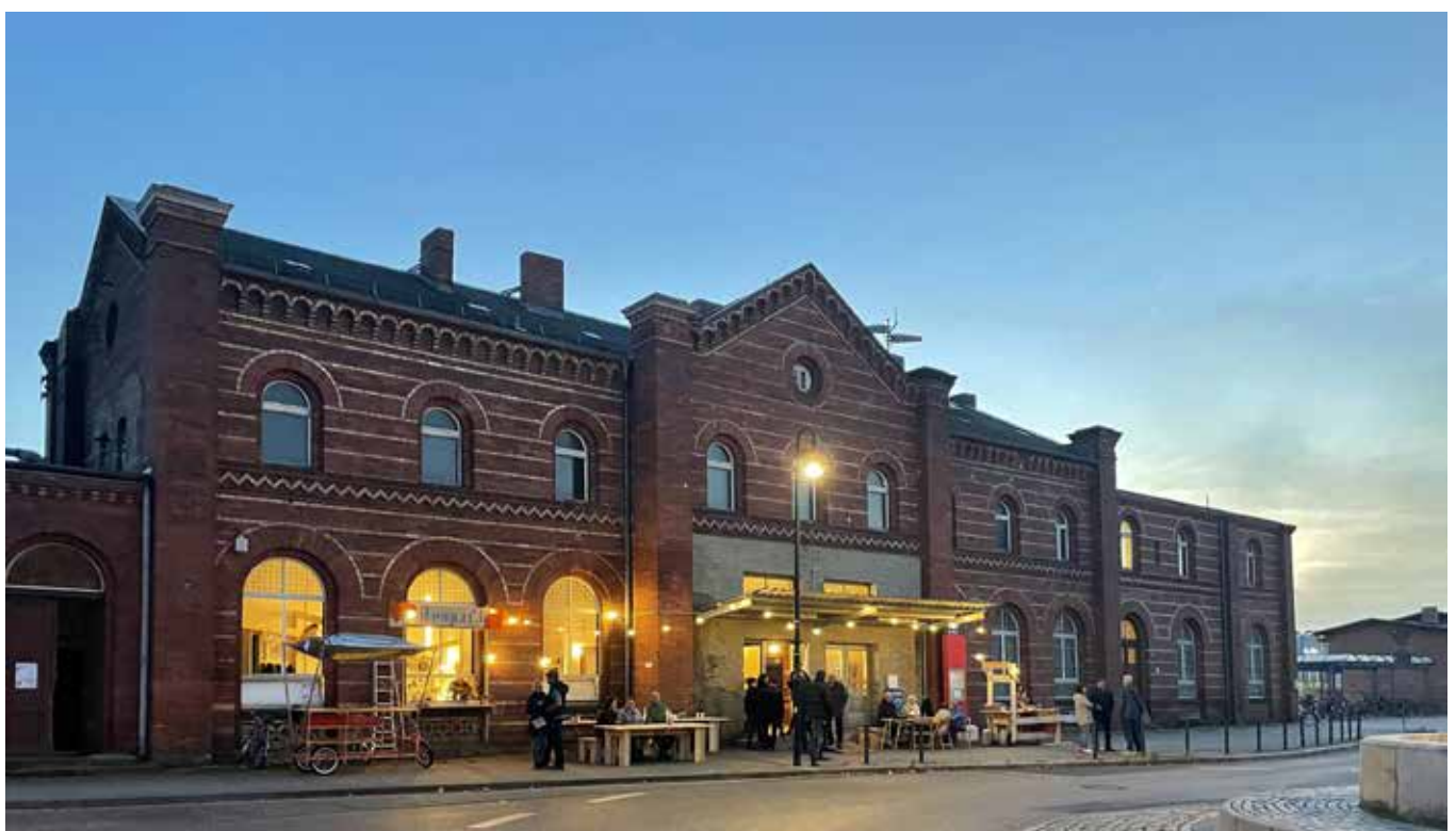
Bahnhofsgebäude während des Baufestivals im Oktober 2022
