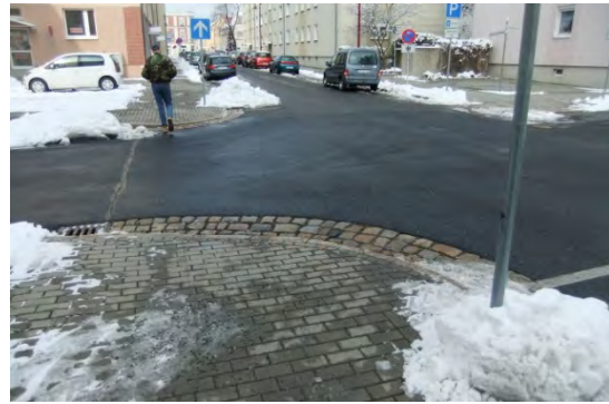
Bordsteinabsenkung Straße der Glasmacher – Barrierefrei?
