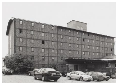
ehem. Glaslager (Neufertbau)
