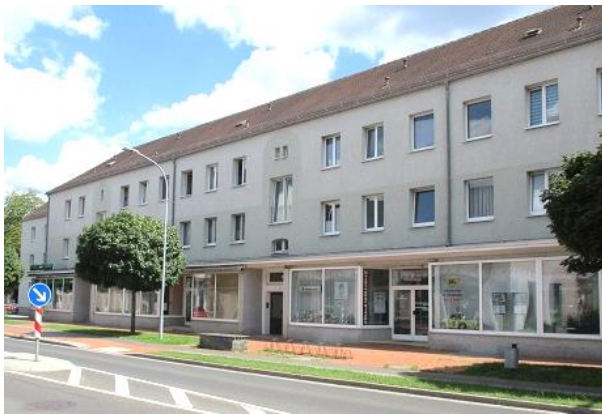
Muskauer Straße – Wohngebäude mit Gewerbeunterlagerung
