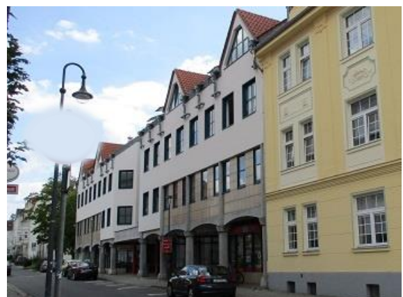
Ersatzneubauten, wie dieses Wohn- und Geschäftshaus in der F.-Bodelschwingh-Straße (Bahnhofsa-real) greifen die Baulinien und Kubatur der früheren Bebauung auf.
