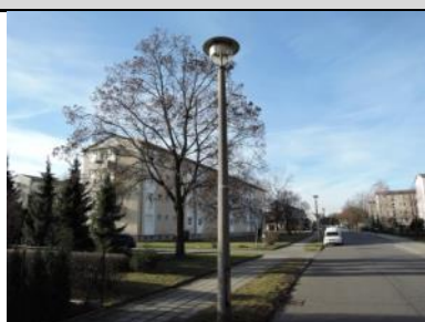
3.1 Gutenbergstraße Straßenbeleuchtung (alt)
