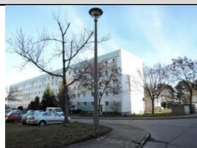
4.2 Bertolt-Brecht-Straße Straßenbeleuchtung (alt)
