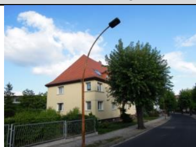
2.2 Schillerstraße Straßenbeleuchtung (alt)
