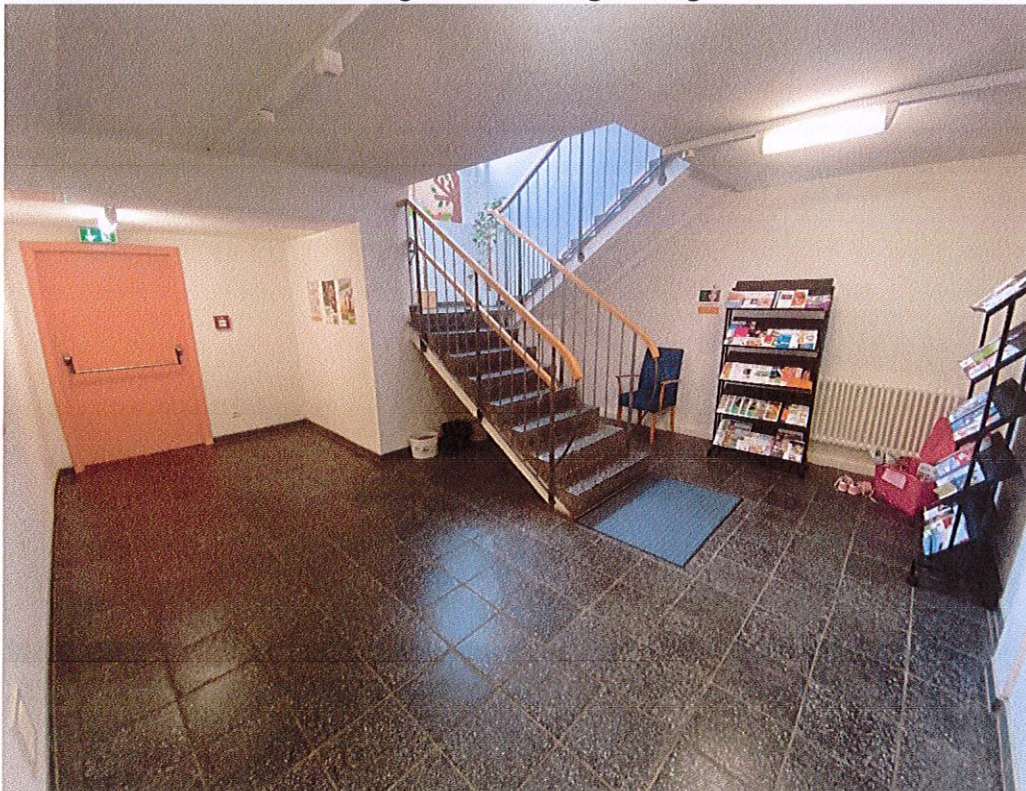
Ansicht des Treppenhauses
