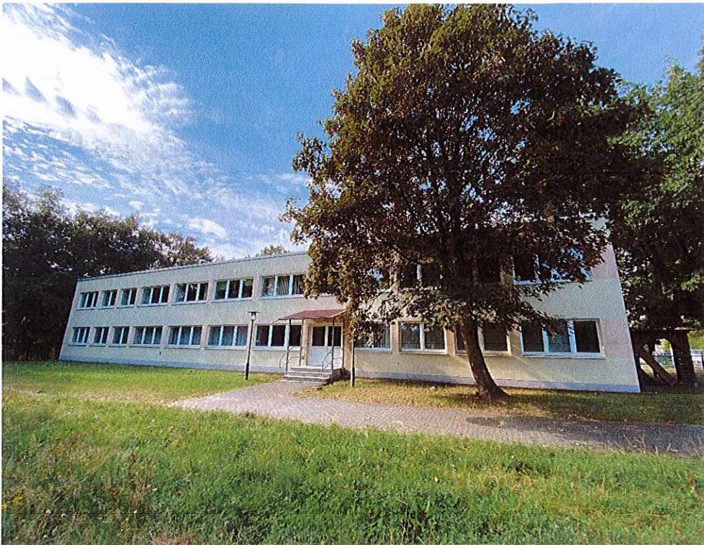
Außenansicht mit Zugang zum ehemaligen Obdachlosenheim
