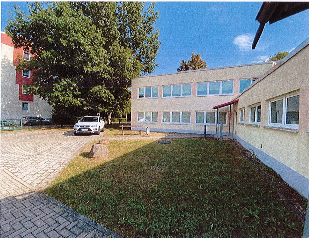
Ansicht Gebäuderückseite vom Innenhof
