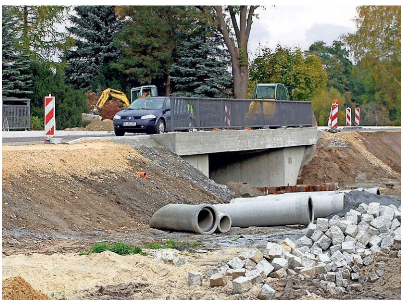
Die Bauarbeiten an der neuen Brücke im Rietschener Ortsteil Hammerstadt stehen kurz vor dem Abschluss, hieß es aus der Gemeindeverwaltung. Ein Eröffnungstermin sei laut Landratsamt noch nicht bekannt. Gegenwärtig wird der fließende Verkehr mit einer Ampel geregelt. Foto: ckx
